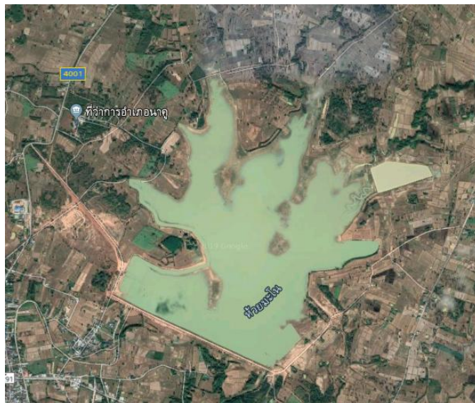
ภาพที่ ๕ อ่างเก็บน้ำและพื้นที่ชลประทาน (ที่มา : กรมชลประทาน)
